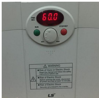
Рисунок 1- SV015iC5-1F Частотный преобразователь
